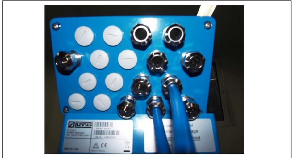
**Abb. 5-26 Eingeführte Sensorkabel Außenansicht Pfad 1**
